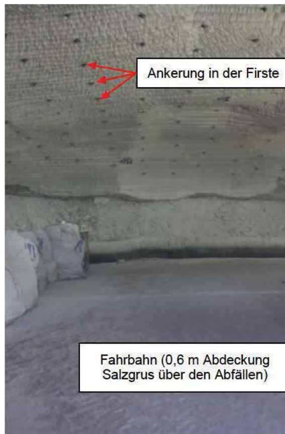
Abbildung 19: Aktuelle First- und Stoßsicherung in der ELK 7/725 mit Blick in Richtung Westen (Aufnahmedatum: 07.03.2016).
